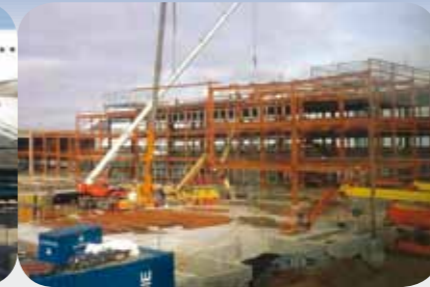
CONSTRUCTION DU NOUVEAU CENTRE D'ESSAIS INTESPACE À ELANCOURT
